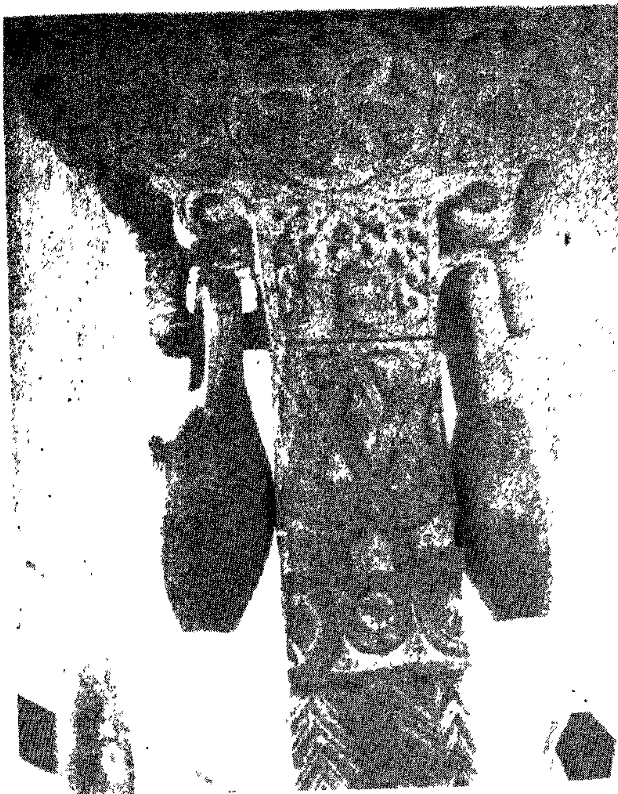
عکس شماره ۱۸ - میله‌ها و حلقه‌های یکی از ستون‌های مسجد متصل به شمع ساختن محمود شاه دیموری
