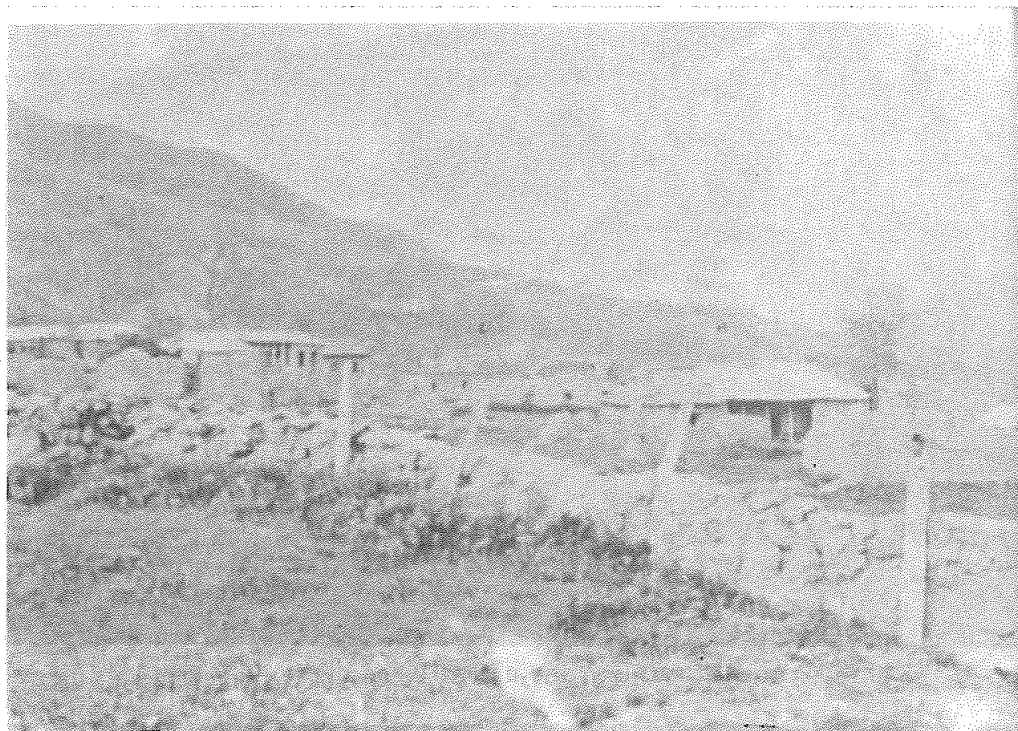
عکس شماره ۲۱۴: چرات پس از زلزله ۱۳۳۶ ه. ش.
