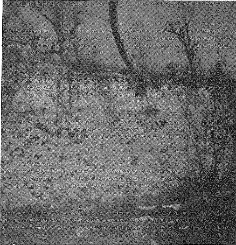
عکس شماره ۳۵۹: خرابه‌های ساختمانهای کنار آب بندان عباس آباد.
